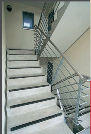
Aussparung für Treppenbelag Sichtbetontreppe mit PVC-Kanten
