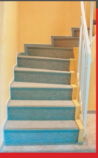
Aussparung für Treppenbelag Sichtbetontreppe mit PVC-Kanten
