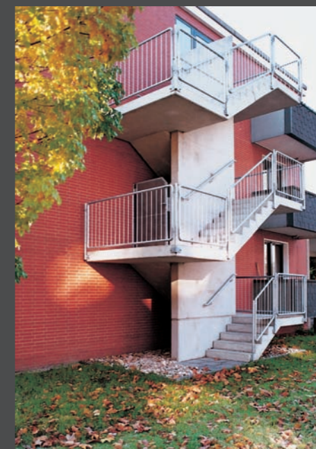
Außentreppe in Sichtbeton aus einzelnen Elementen.
