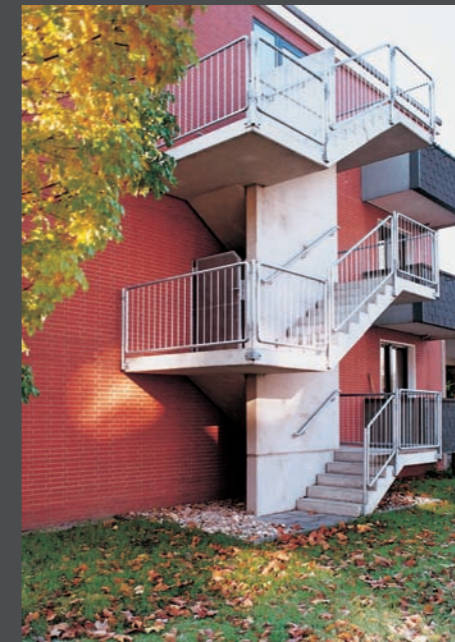
Außentreppe in Sichtbeton aus einzelnen Elementen.
