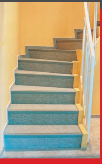
Aussparung für Treppenbelag Sichtbetontreppe mit PVC-Kanten
