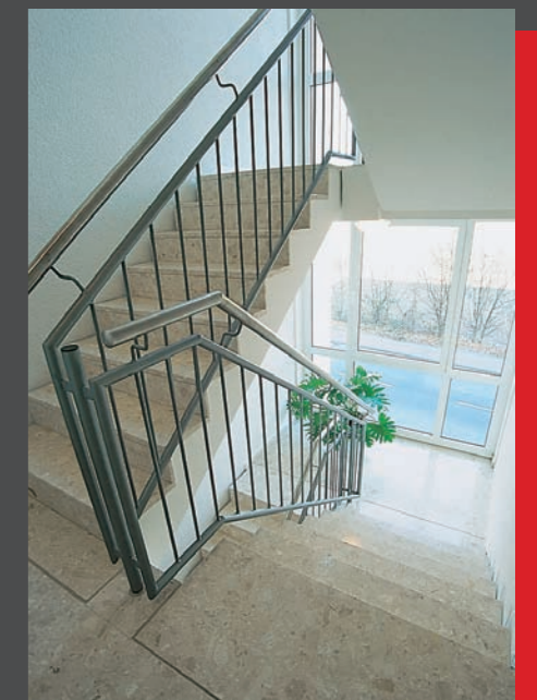
Im Werk fix und fertig mit Natur- oder Kunststein belegte Fertigteiltreppe
